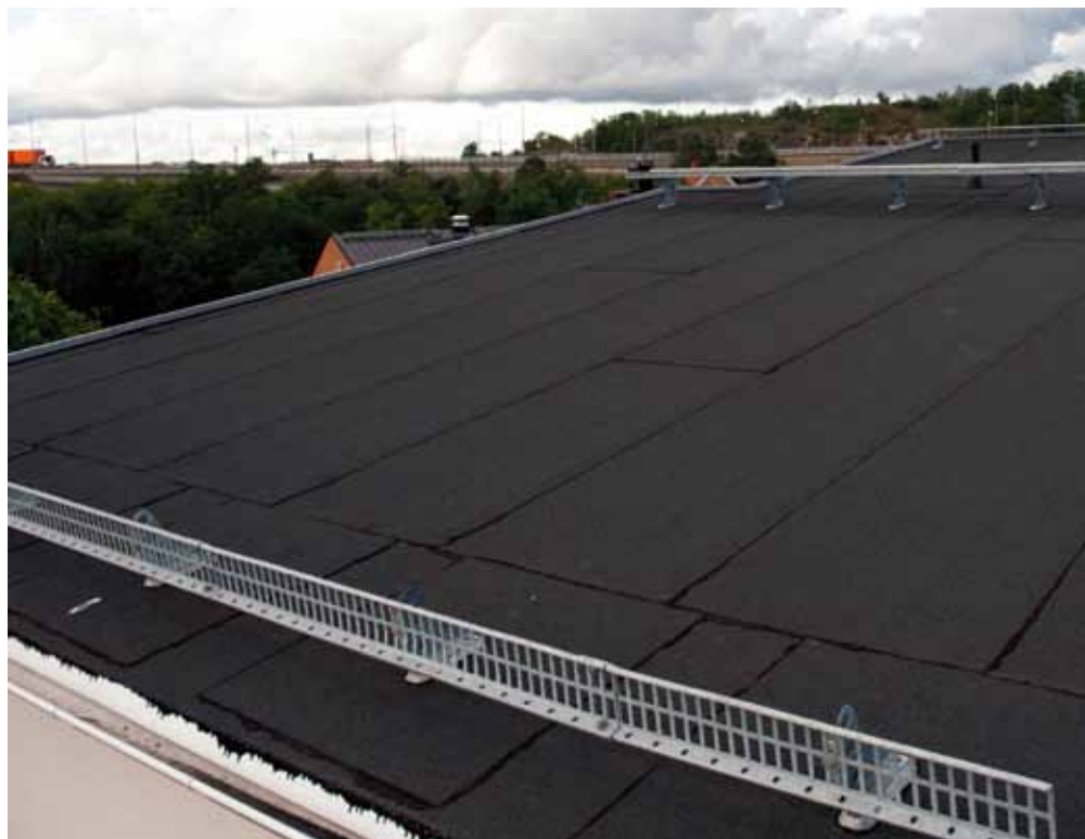
Brf Ekensbergsparkens tak är utrustade med snörasskydd, gångbryggor och nockräcken.
