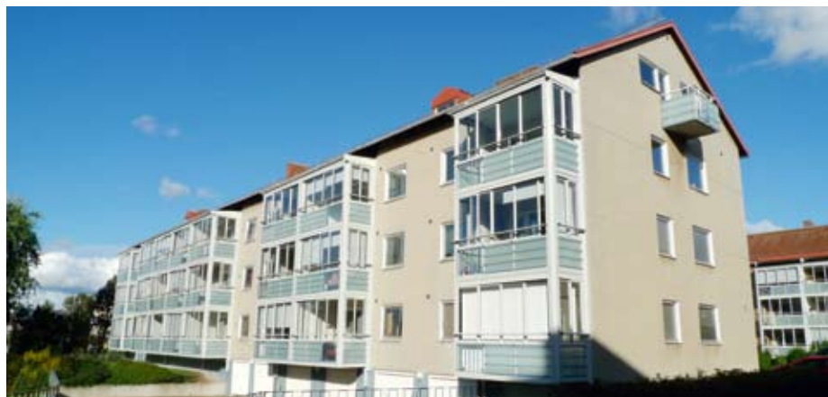
Efter: En helt ny fasad där varje lägenhet fått ett rejält uterum och samtidigt ett väremisolerande luftutrymme mot rummet innanför.
