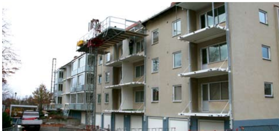
Under: Ombyggnaden har börjat. De indragna balkongerna får nya, bredare plattor och glasa in.
