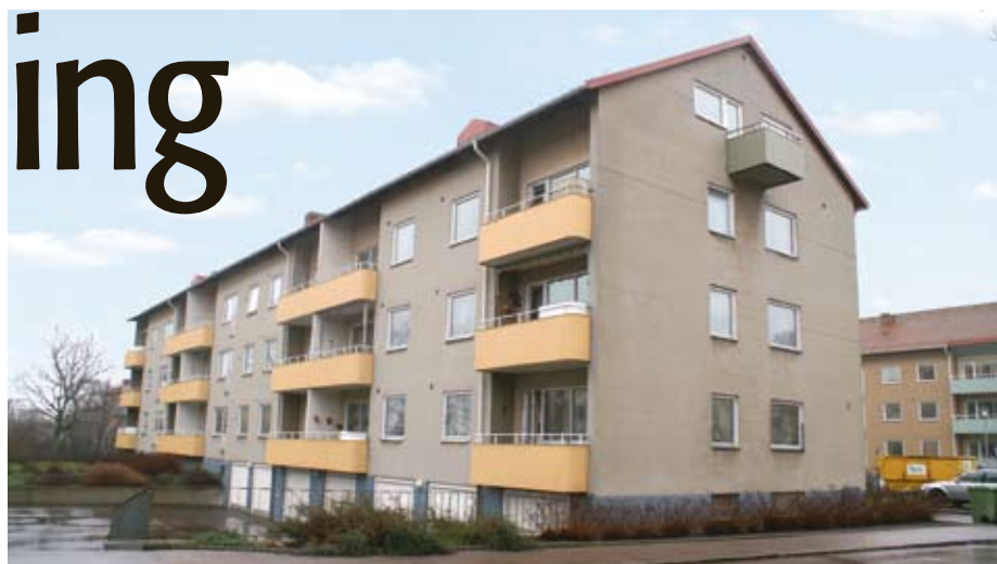
Före: Ett av företaget Balcos ombyggnads- och inglasningsprojekt i Riksbyggens Brf Ängelholms-hus.
