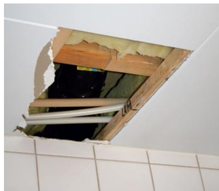
Rörmokaren tvingades såga upp en lucka i väggen på radhusets andra våning för att komma åt läckan som orsakade taktropet på undervåningen.
