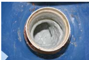
Jürgen Hawlitzky demonstrerar Prolinemetoden som plastar rören (bilderna t v). Men Brf Venus har också valt "strumpmetoden" där en inplastad strumpa läggs in i stammarna, här ifrån taket.
