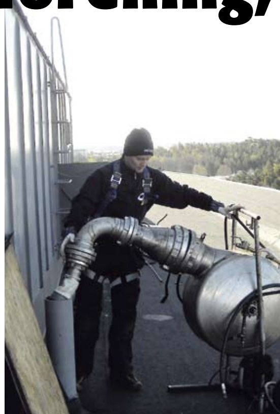
Jürgen Hawlitzky demonstrerar Prolinemetoden som plastar rören (bilderna t v). Men Brf Venus har också valt "strumpmetoden" där en inplastad strumpa läggs in i stammarna, här ifrån taket.
