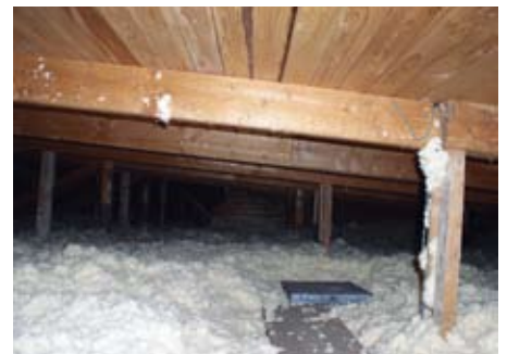
25 cm träfiberisolering på Brf Pernaus vind ger en energibesparing på drygt 15 procent.
