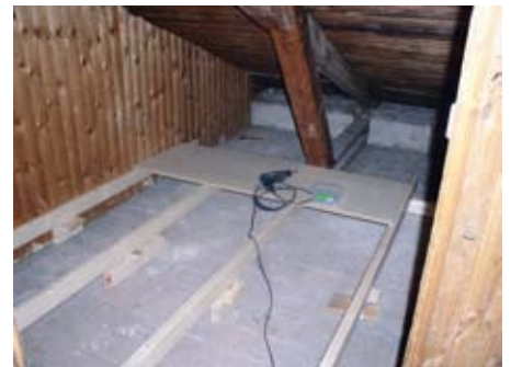
Det går utmärkt att isolera under vindsförråd.
