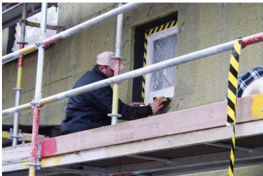
Genom att flytta fönstren längre fram undviker man alltför stora förändringar av husets ursprungliga utseende
