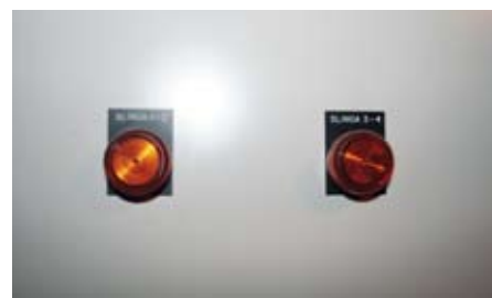
Kolla så att inte elslingorna står på i onödan.
