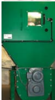
Under luckan, nere i källaren, finns husets sopsugningsmaskin.
