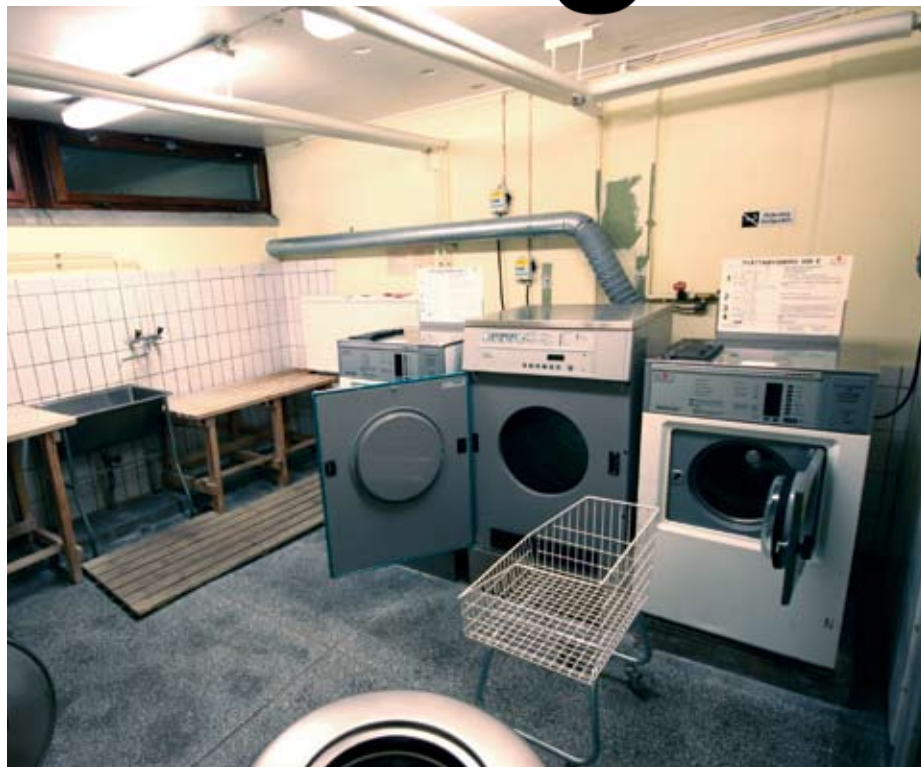
Är maskinerna mer än 15 år gamla bör de bytas ut, enligt Karin Fant, energi- och klimatrådgivare på Energirådgivningen i Stockholm.
