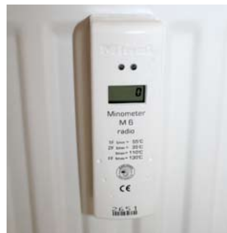
Den tillförda värmen från varje element mäts.
