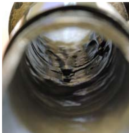
Droppbildning i relinat rör. Här har plasten sprutats på i en stående stam.
